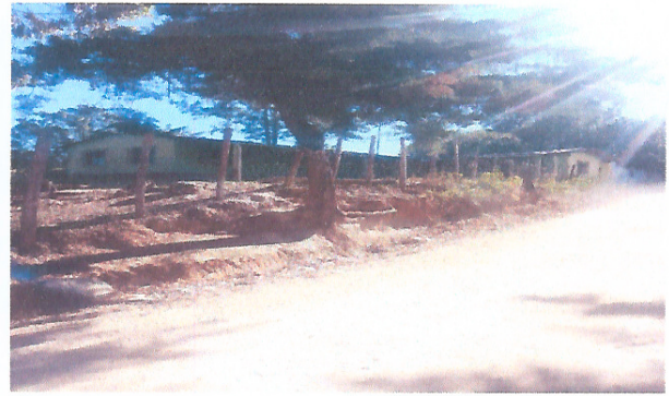
Foto 2: Mejoramiento de cerco perimetral
