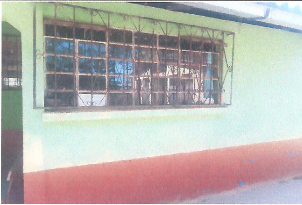
Foto 3: Mejoramiento de pintura exterior
