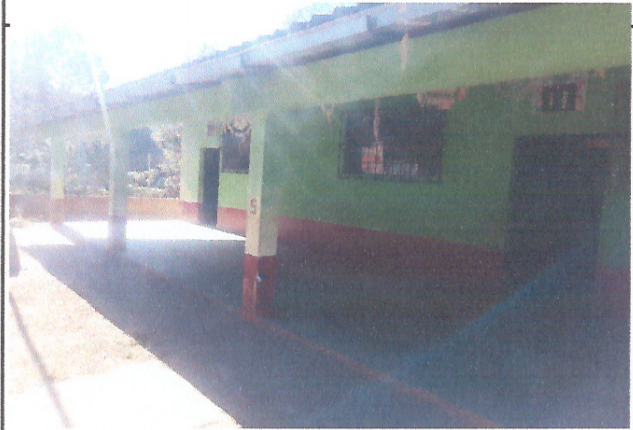
Foto 4: Mejoramiento de pintura interior
