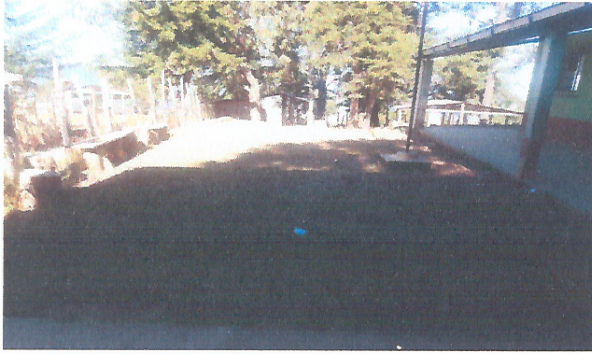
Foto 1: Mejoramiento de losa de patio
